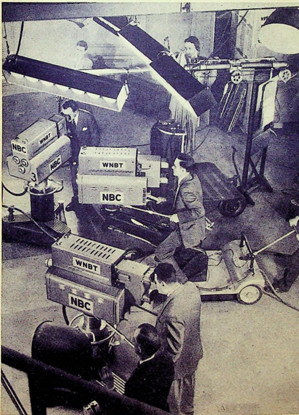
Blick in ein Fernsehstudio der NBC, New York. Ähnlich wie der Rundfunk verschiedene Mikrofone verwendet, bedient sich auch das Fernsehen zahlreicher Aufnahme-Kameras, um Nahaufnahmen und Einzelheiten übertragen zu können. Die Beleuchtungslampen sind zu Strahlergruppen zusammengefaßt. (Foto: NBC, New York)
